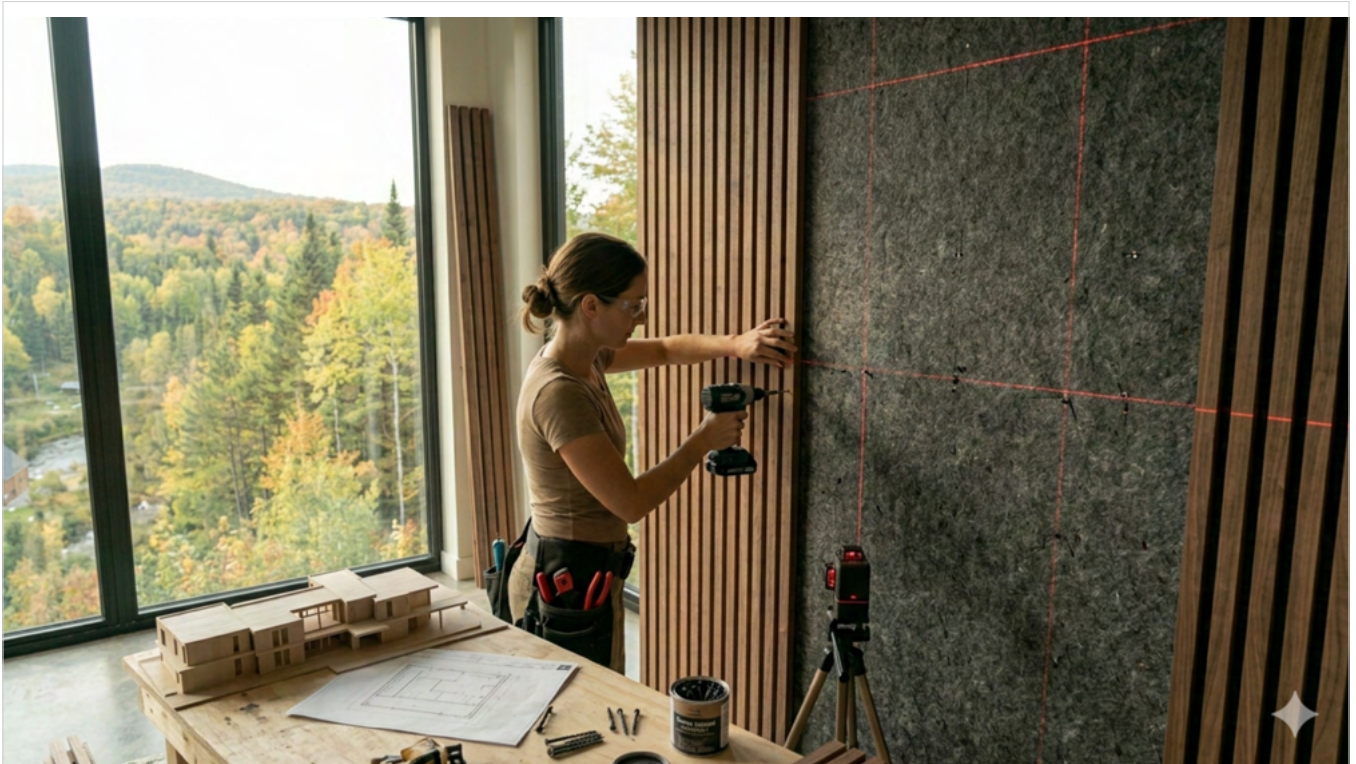
Pose du panneau au mur avec contrôle de l'alignement.
